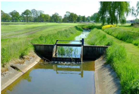
AFBEELDING 3.10 KLEPSTUW MET BETONNEN UITSTROOMBAK
