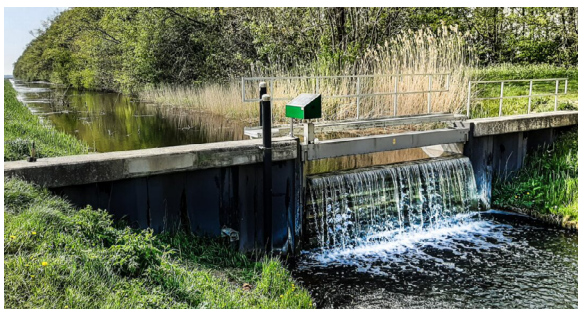
AFBEELDING 3.11 REGELBARE STUW ZONDER UITSTROOMBAK
