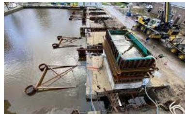
5. Werkzaamheden aan kleine kades/kademuren (primair en secundaire waterkeringen)
