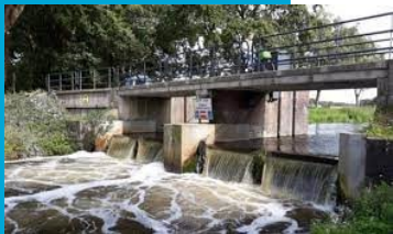
3. Werkzaamheden aan civieltechnische constructies (CT)
