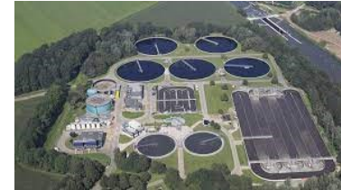
4. Werkzaamheden aan rioolwaterzuiveringsinstallatie (RWZI)
