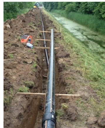
In de open ruimte een geul graven
