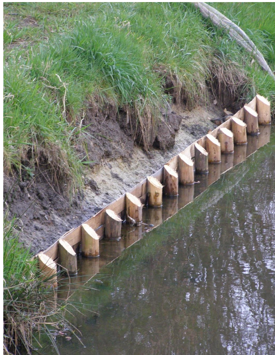
Houten oeverbescherming van palen en planken
